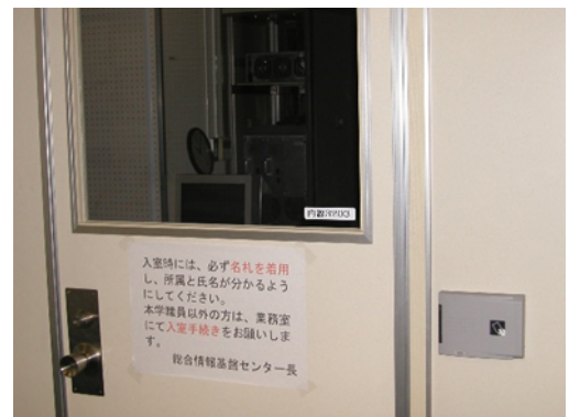
図 4.6 コンピュータ室入口の入退室管理
