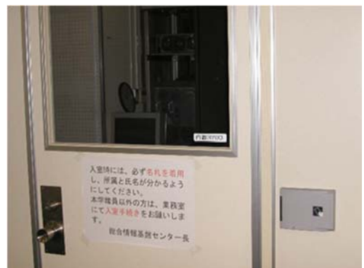
図 4.6 コンピュータ室入口の入退室管理
