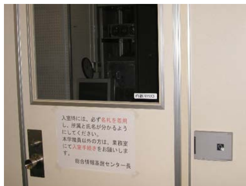
図 4.6 コンピュータ室入口の入退室管理
