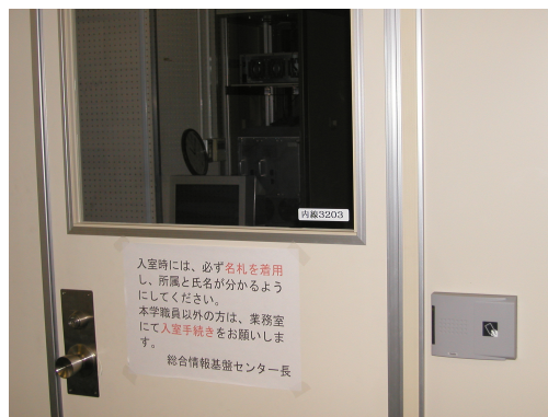
図 4.11: コンピュータ室入り口の入退室管理
