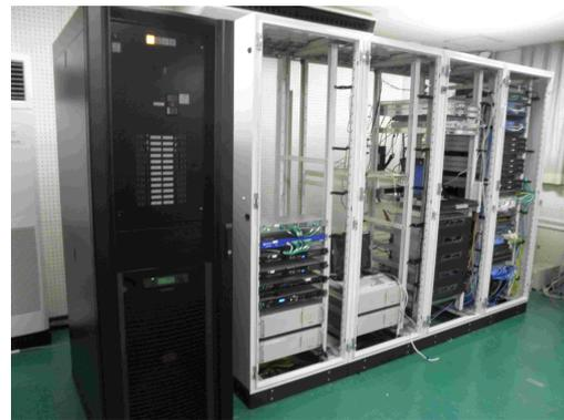
図 4.9: 新キャンパス情報ネットワークシステムのラック配置。一番左が無停電電源装置
